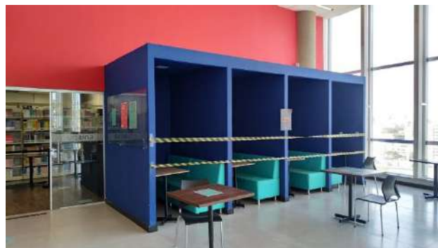
Figura 5: Construção de espaço para estudos na Biblioteca.
