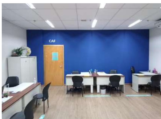
Figura 12: Construção de uma porta para comunicação interna CAF-Coordenação.
